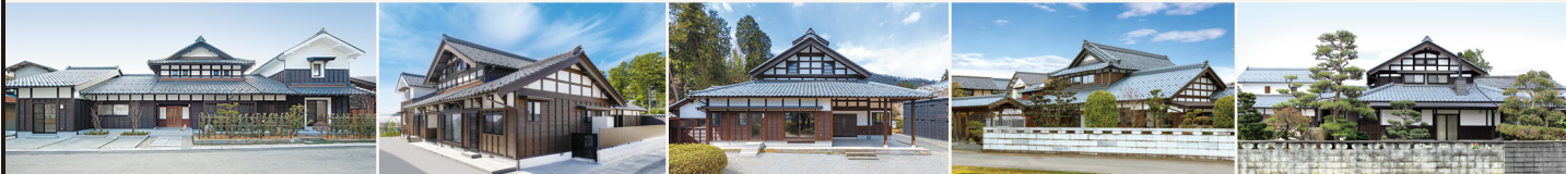
明治28年築の民家再生の様子
